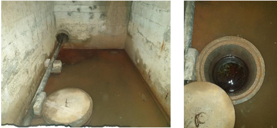
Abb. 4.12 und 4.13: Quellschacht 9.1 (Fotos L&H; 29.3.2023)
