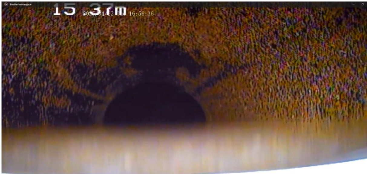
Abb. 4.7: Ende der Zementrohrleitung vor dem überdeckten Schacht
