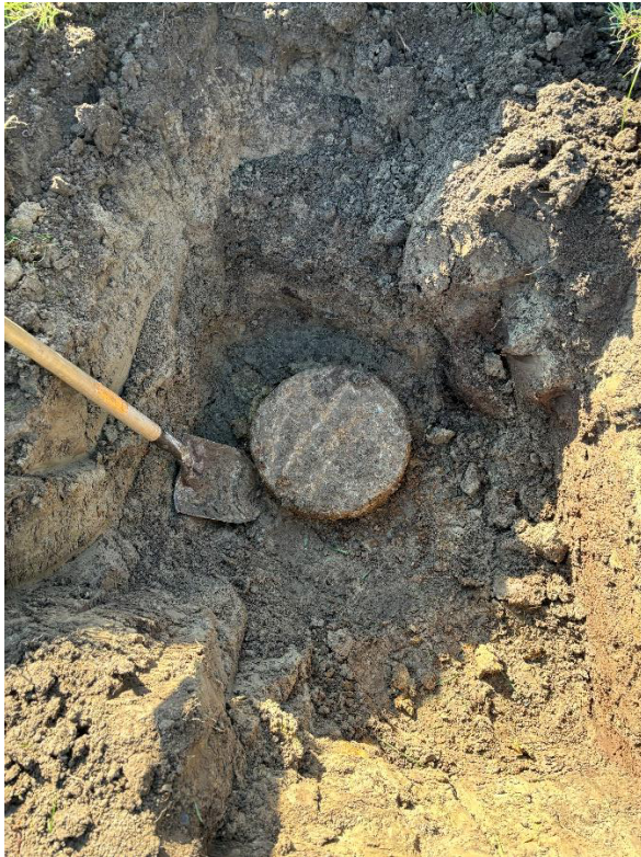
Abb. 4.5: Sondage Quellschacht bei Quelle 8.3 (Foto L&H 3.4.2025)
