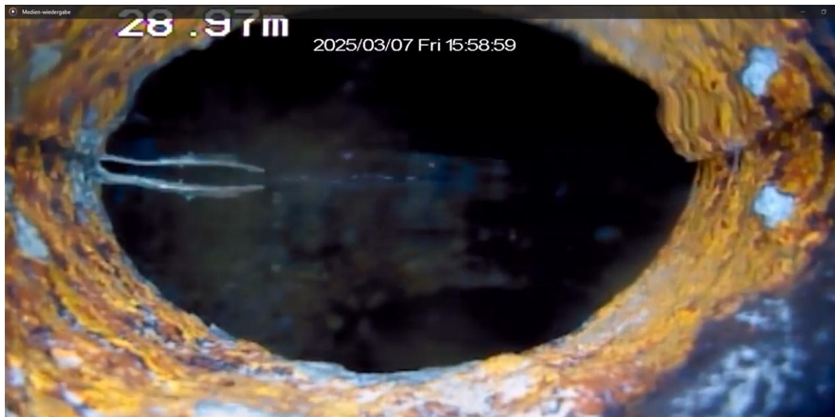
Abb. 4.3: Quelle 8.3: Ende der Eisenleitung vor dem überdeckten Schacht
