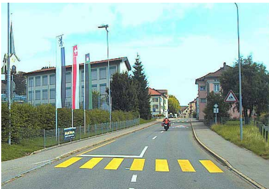
Die Fussgängerquerung der Urnäserstrasse beim Schulhaus in Waldstatt wird verlegt und mit einer Mittelinsel versehen.
