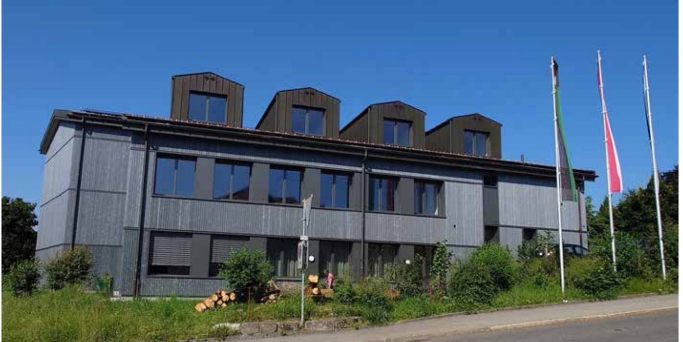
Oberstufenschulhaus erfolgreich saniert
