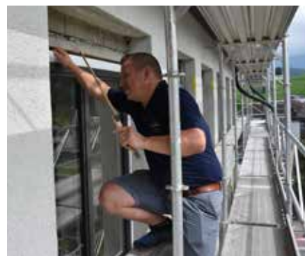
Markus Bösch ist zufrieden mit den neuen Fenstern.
